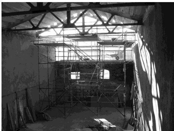
Fig. 11. Desmuntatge de la façana sud. Font: els autors
