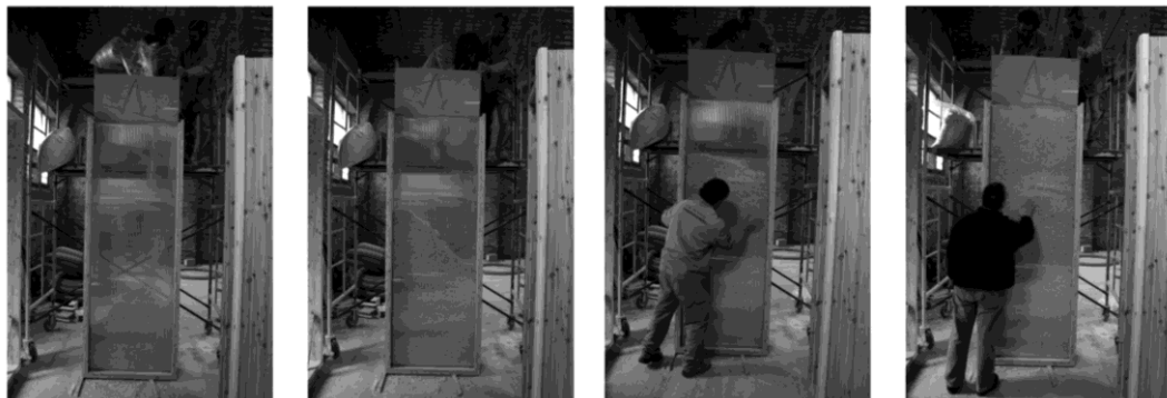
Fig. 27. Muntatge d'un tancament reomplert amb encenalls de fusta reciclats, (Cal Massó). Font: els autors
