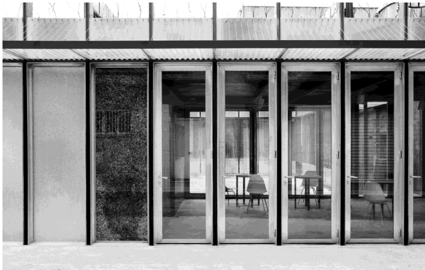
Fig. 28. Un dels tancaments de façana reomplert amb fragments de vidre reciclat, (Cal Massó).
