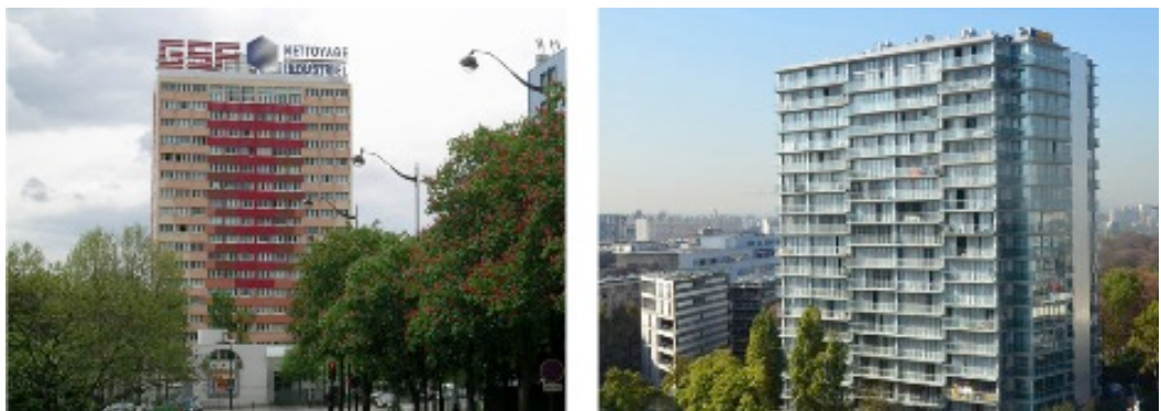
Fig. 12 Lacaton&Vassal, Projecte Tour Bois-le-Prete: estat inicial i estat reformat
